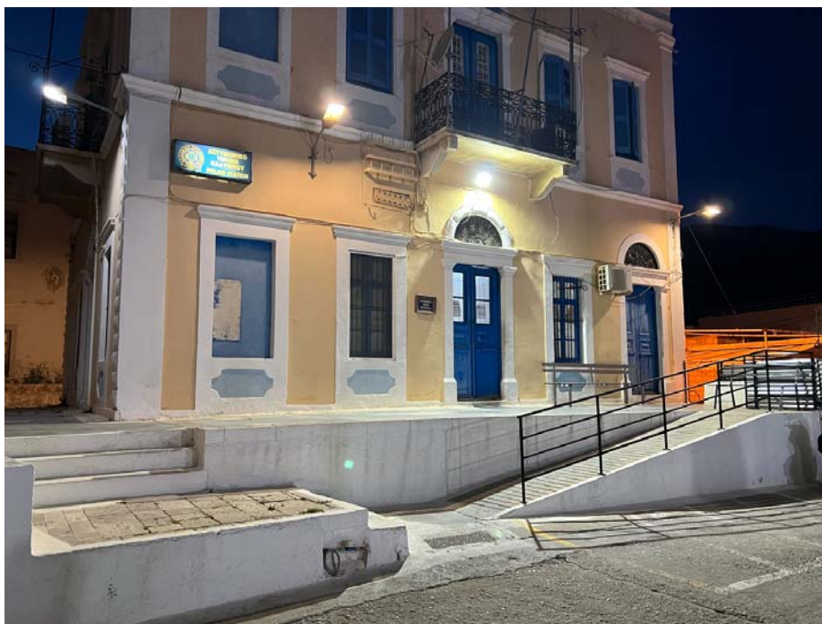
Εικόνα 3.3 Αστυνομικό τμήμα Καλύμνου
